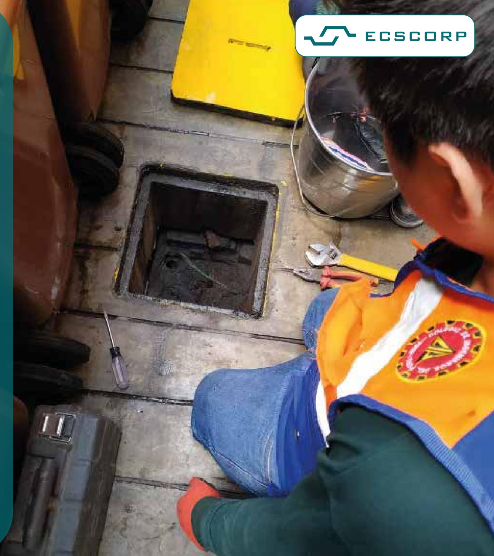
El mantenimiento de pozos a tierra es un procedimiento que sirve para recuperar las condiciones óptimas dentro de lo posible para que un Pozo a Tierra ofrezca la más baja resistencia al paso de la corriente eléctrica de falla o desfogue.
